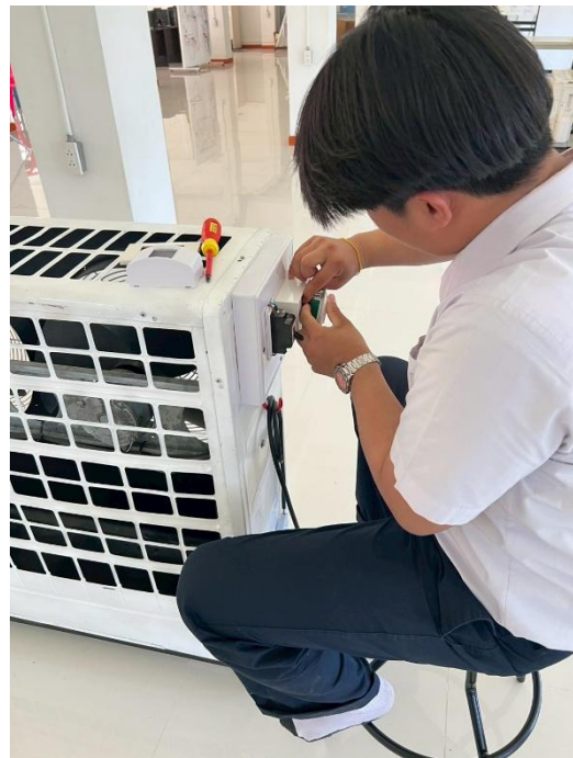
รูปภาพที่ 7 ขั้นตอนการติดตั้งพัดลม
