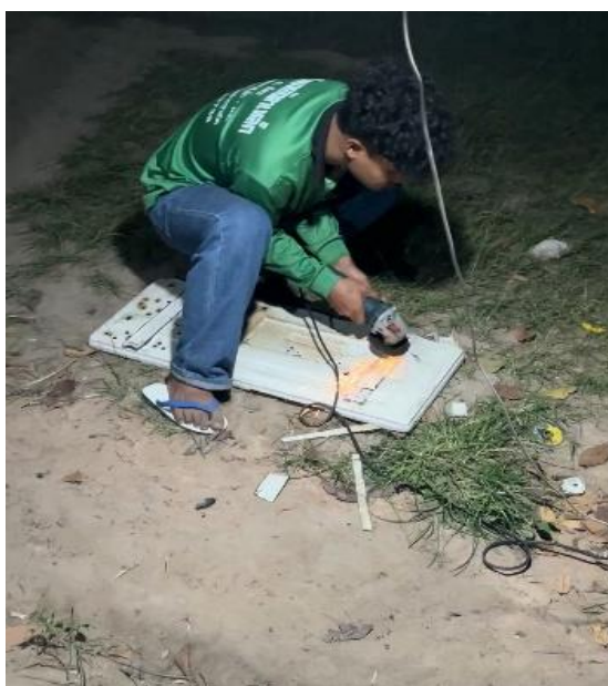
รูปภาพที่ 4 ขั้นตอนการทำโครงเหล็ก
