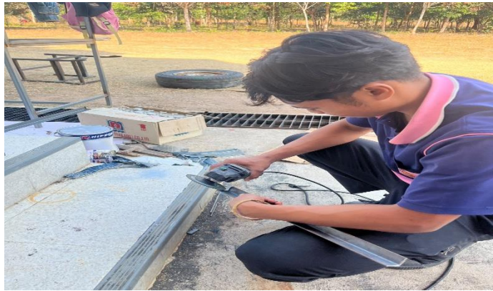
ภาพที่ 4 การเจียแต่งผิว (ที่มา : นางสาวธัญวรรณ พรหมพิลา และคณะ 2568)
