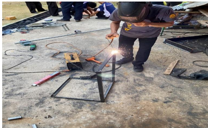
ภาพที่ 2 การเชื่อมชิ้นโครง (ที่มา : นางสาวธัญวรรณ พรหมพิลา และคณะ 2568)
