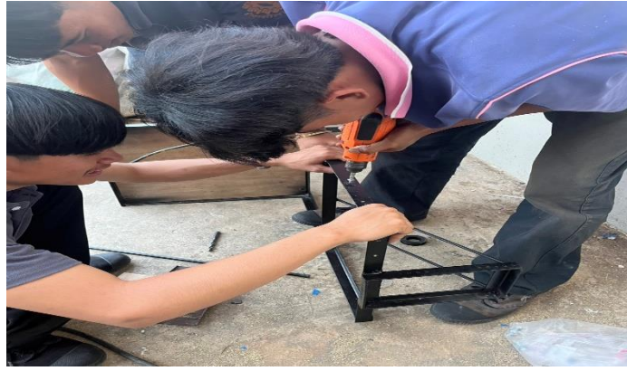
ภาพที่ 3.2.9 การติดตั้งคัตเอาต์ (ที่มา : นายจรรย์ศ ทงประเสริฐ และคณะ 2568)
