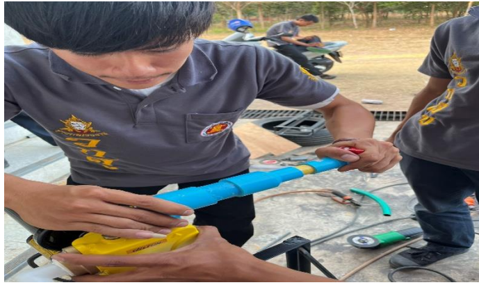
ภาพที่ 3.2.11 การต่อท่อ (ที่มา : นายขจรยศ ทองประเสริฐ และคณะ 2568)
