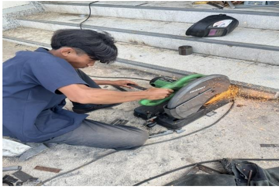
ภาพที่ 3.2.1 การตัดเหล็กทำโครง (ที่มา : นายขจรยศ ทองประเสริฐ และคณะ 2568)
