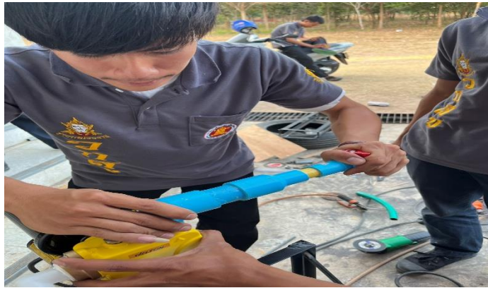
ภาพที่ 3.2.11 การต่อท่อ (ที่มา : นายจรรย์ศ ท้องประเสริฐ และคณะ 2568)
