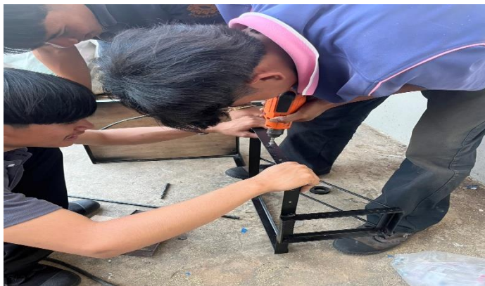
ภาพที่ 3.2.9 การติดตั้งคัตเอาท์ (ที่มา : นายจรรย์ศ ทอประเสริฐ และคณะ 2568)
