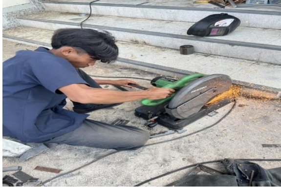
ภาพที่ 3.2.1 การตัดเหล็กทำโครง (ที่มา : นายขจรยศ ทองประเสริฐ และคณะ 2568)
