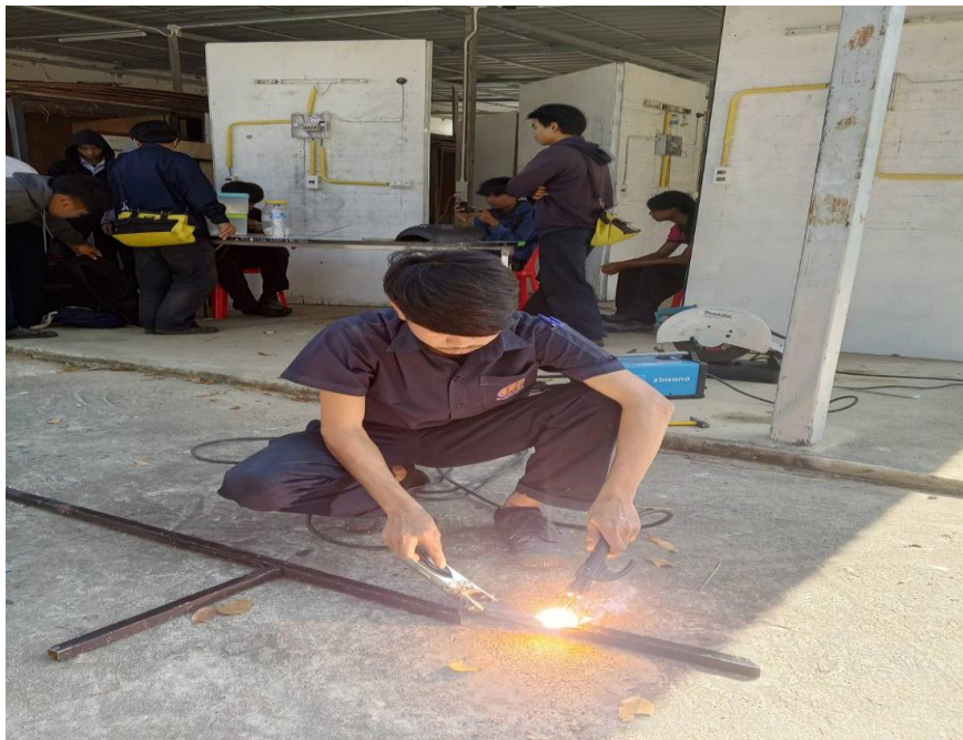
รูปภาพที่ 6 การเชื่อมโครงเหล็กเพื่อประกอบชิ้นงาน
