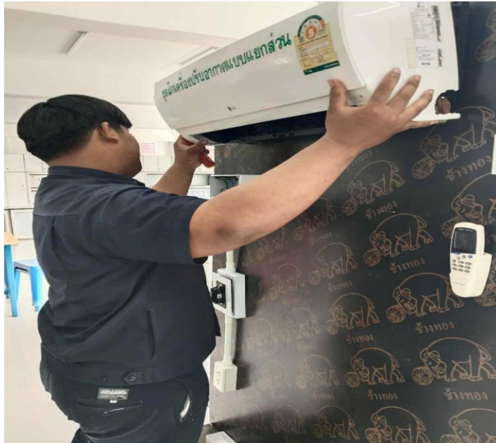
รูปภาพที่ 9 ติดตั้งฐานชุดแอร์ด้านหน้า
