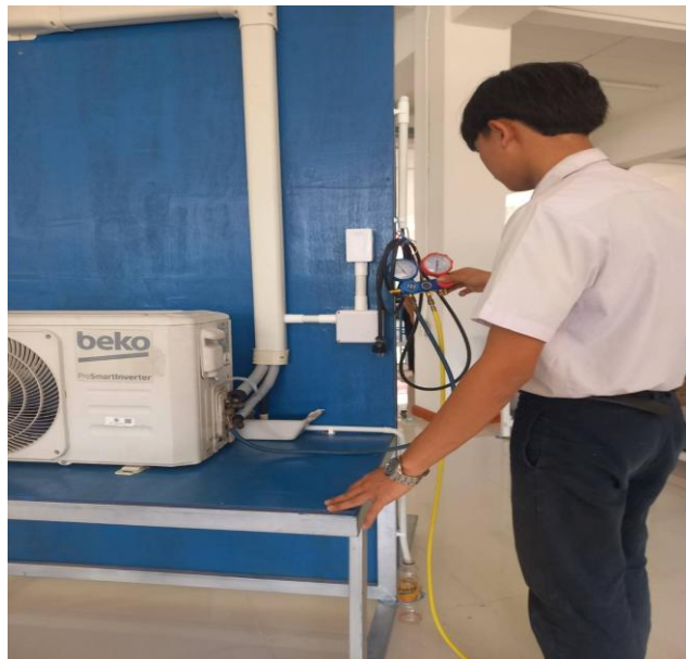
รูปภาพที่ 12 ทำเดินระบบน้ำยาและวัดระดับน้ำยาในระบบ
