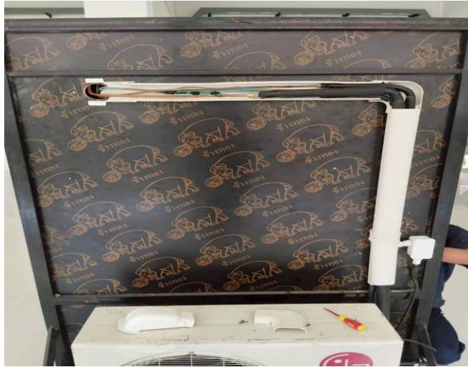
รูปภาพที่ 11 นำท่อทองแดงและฟารางมาประกอบเพื่อการเดินระบบน้ำยาเครื่องปรับอากาศ
