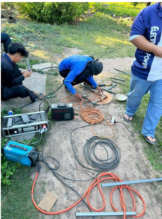
รูปภาพที่ 3 การเชื่อมโครงเหล็กเพื่อประกอบชิ้นงาน
