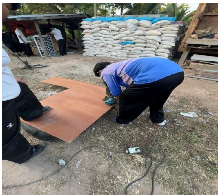
รูปภาพที่ 4 ตัดไม้แผ่นตามขนาดโครงสร้าง
