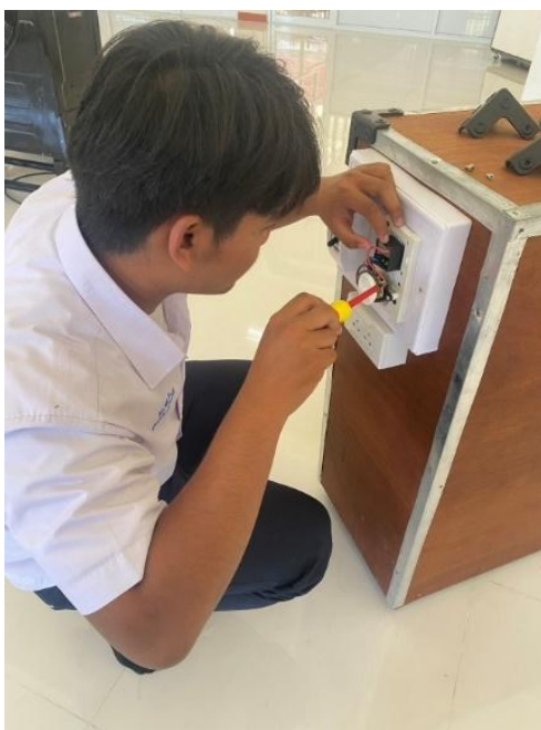
รูปภาพที่ 8 ขั้นตอนการติดตั้งวงจรควบคุม
