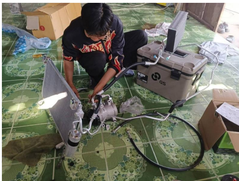
รูป 3.2.3.3.1 เครื่องย่ำสายน้ำยาแอร์, เกจวัดมณีโพลต์
