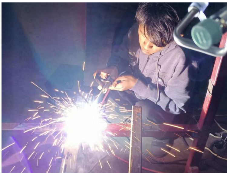
ภาพที่ 3.3.1 แสดงการเชื่อมประกอบโครงสร้างเหล็ก
