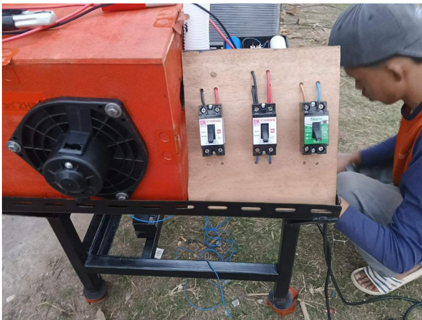
ภาพที่ 10 การติดตั้งแผงสวิตช์ควบคุม (สวิตช์กัญแจ, สวิตช์พัดลม และสวิตช์ A/C)
