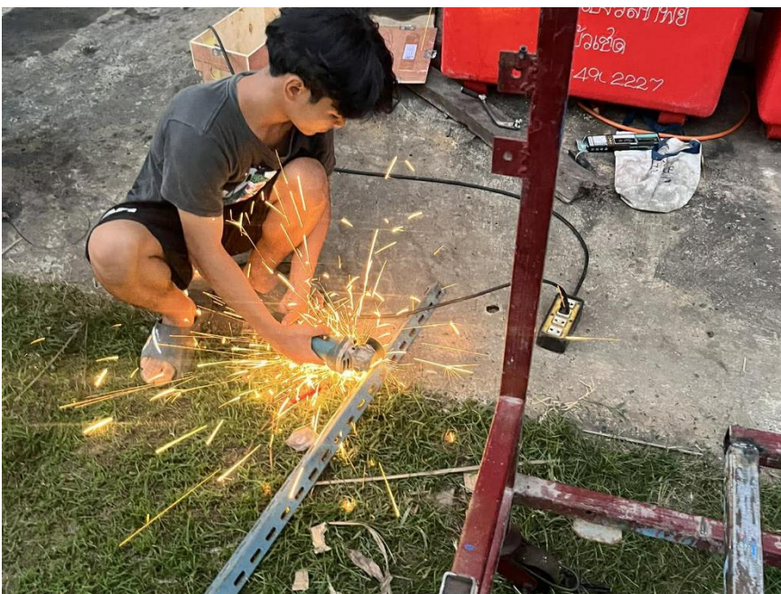
ภาพที่ 4 การเชื่อมประกอบโครงสร้างเหล็กและการติดตั้งล้อเลื่อน
