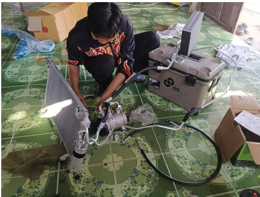
ภาพที่ 8 การติดตั้งระบบท่อทางเดินน้ำยาแอร์และสายน้ำยา
