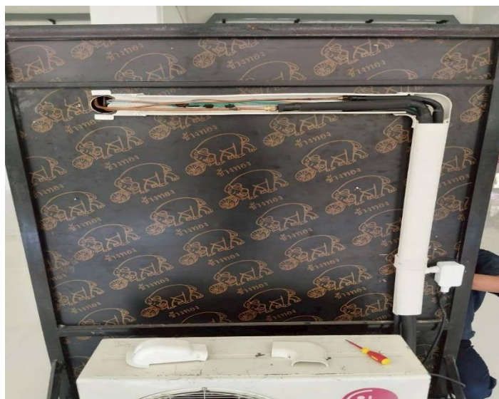
รูปภาพที่ 19 นำท่อทองแดงและฝารางมาประกอบเพื่อการเดินระบบน้ำยาเครื่องปรับอากาศ
