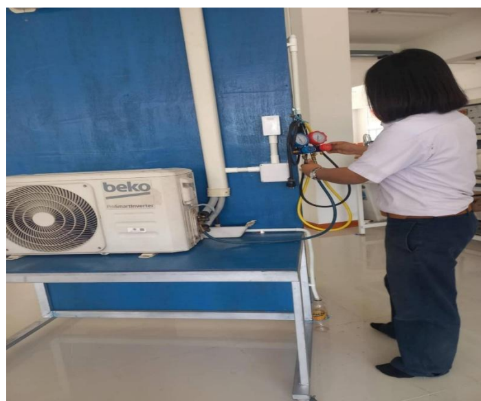
รูปภาพที่ 19 นำท่อทองแดงและฝารางมาประกอบเพื่อการเดินระบบน้ำยาเครื่องปรับอากาศ
