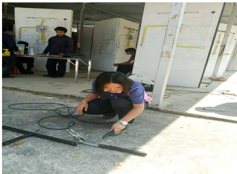
รูปภาพที่ 5 การเชื่อมโครงเหล็กเพื่อประกอบชิ้นงาน
