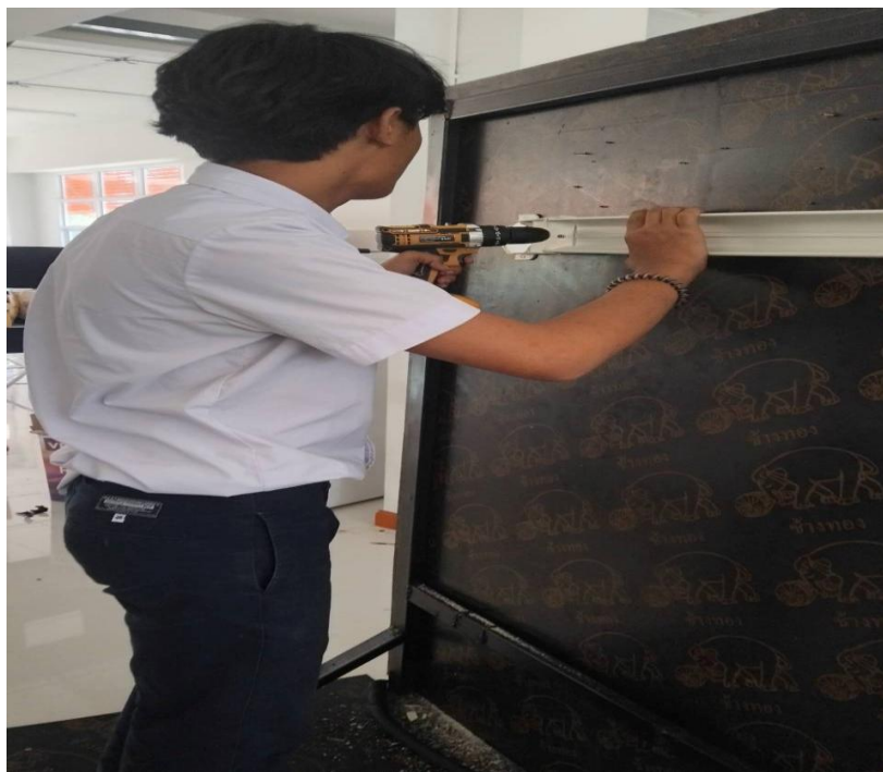
รูปภาพที่ 7 เจาะรูเพื่อนำชุดแอร์ด้านหน้ามาประกอบ
