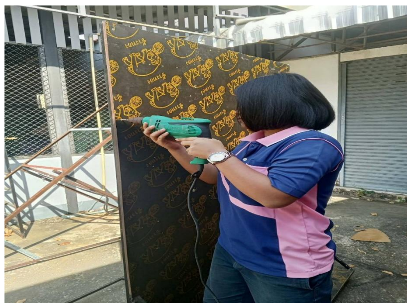
รูปภาพที่ 6 นำกระดาษไม้อัดมาตัดเพื่อประกอบกับเหล็กที่เชื่อม
