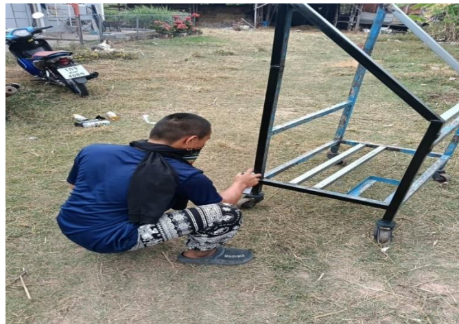
ภาพที่ 3.6 การพ่นสีโครงสร้างเหล็กเพื่อเพิ่มความสวยงามและป้องกันการเกิดสนิมและทำให้โครงงานสวยงามและน่าดู
