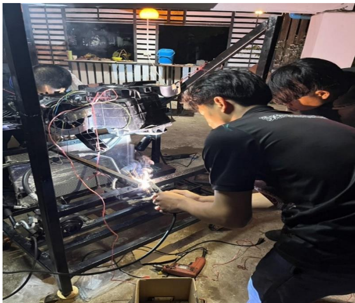
ภาพที่ 3.10 เชื่อมอุปกรณ์ เชื่อมขาคเหล็กเพื่อลองน้ำหนกของตู้แอร์และยิงน็อตติดที่ขาเหล็กเพื่อในการลองทดสอบในการใช้งานให้ตู้แอร์ไม่ขยับและทำการต่อสายไฟ
