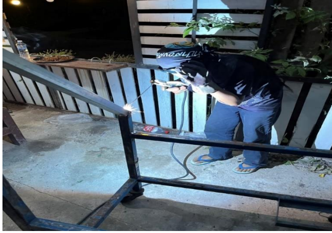
ภาพที่ 3.5 เชื่อมโครงใหม่ ดำเนินการเชื่อมและติดตั้งโครงสร้างเหล็กที่ตัดมาใหม่เพื่อเอากระดานไม้มาติดเป็นแนว เฉียงตามแบบที่กำหนดและทำเป็นสื่อการสอนชุดฝึกปรับอากาศรถยนต์
