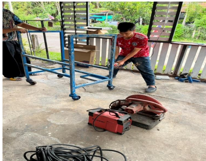
ภาพที่ 3.4 ตัดโครงเหล็กเดิม ขั้นตอนการตัดและรื้อถอนโครงเหล็กส่วนที่ชำรุดออกจากโครงสร้างเดิม เพื่อเตรียมความพร้อมสำหรับการปรับปรุงและติดตั้งชิ้นส่วนใหม่และความพร้อมสำหรับการประกอบ
