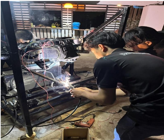
ภาพที่ 3.10 เชื่อมอุปกรณ์ เชื่อมขาเหล็กเพื่อลองน้ำหนักรถของตู้แอร์และยิงน็อตติดที่ขาเหล็กเพื่อในการลองทดสอบในการใช้งานให้ตู้แอร์ไม่ขยับและทำการต่อสายไฟ
