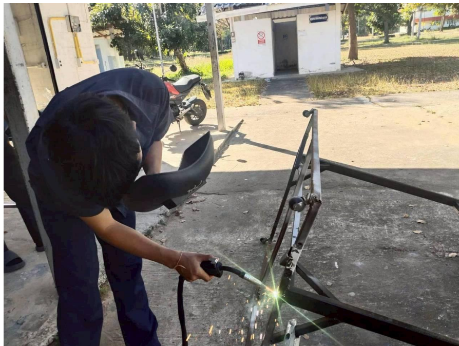
รูปภาพที่ 6 การเชื่อมโครงเหล็กเพื่อประกอบชิ้นงาน
