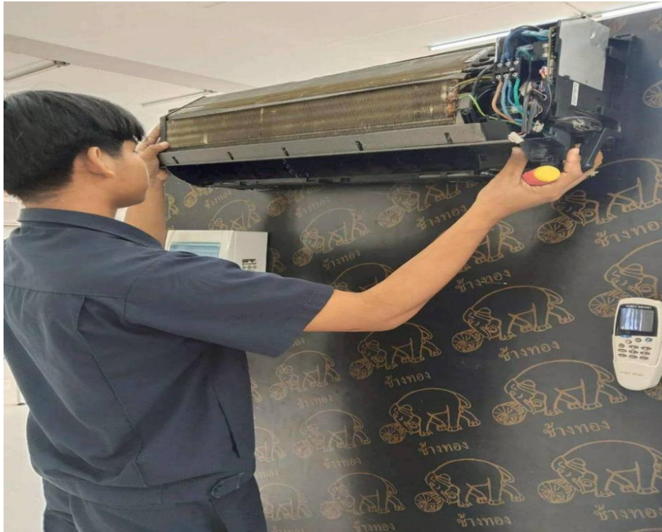
รูปภาพที่ 9 ติดตั้งฐานชุดแอร์ด้านหน้า
