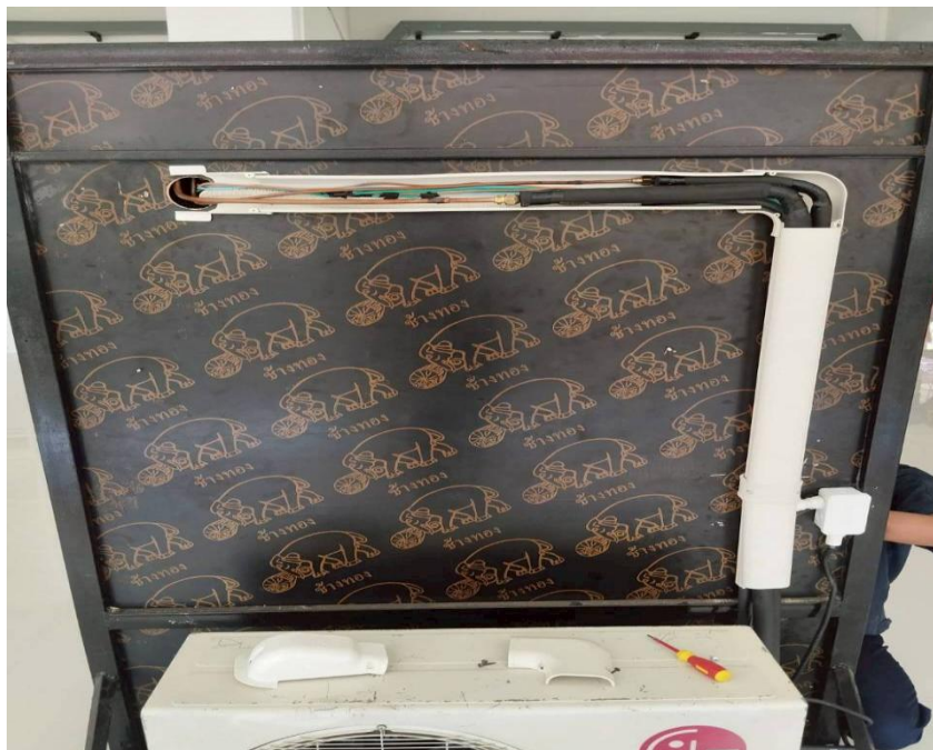
รูปภาพที่ 11 นำท่อทองแดงและฝารางมาประกอบเพื่อการเดินระบบน้ำยาเครื่องปรับอากาศ
