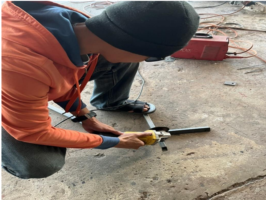
รูปภาพที่ 5 ทำการตัดเหล็กเพื่อทำการขึ้นโครง
