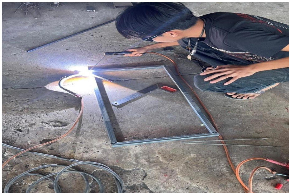
รูปภาพที่ 6 การเชื่อมโครงเหล็กเพื่อประกอบชิ้นงาน
