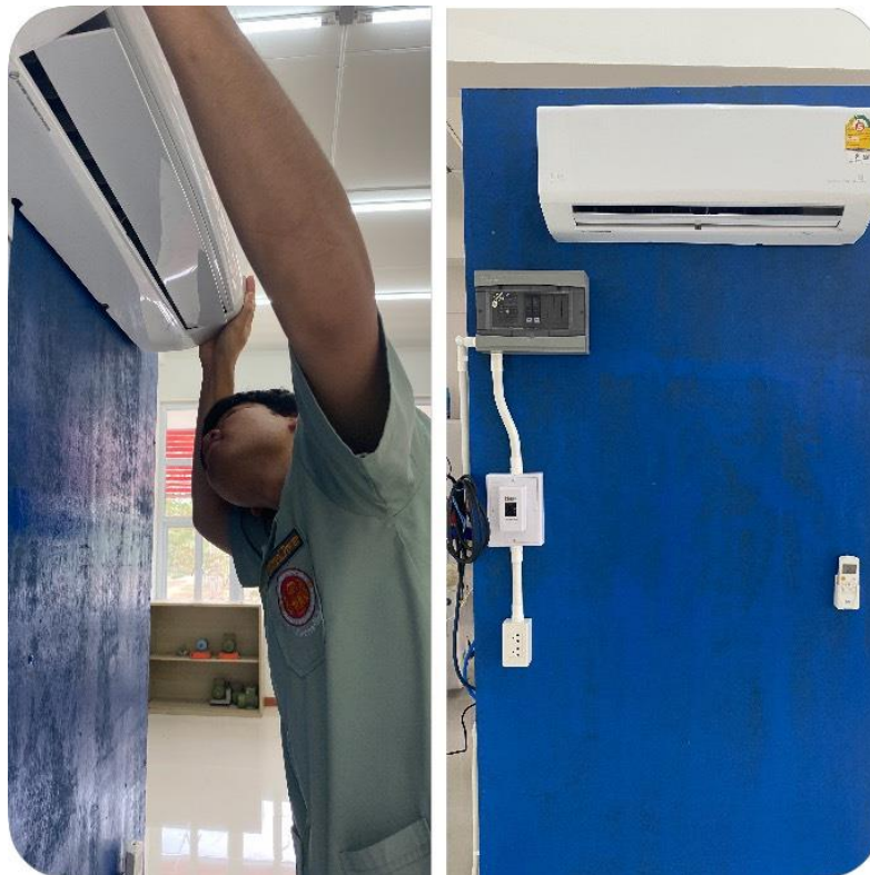
รูปภาพที่ 10 นำฝาด้านหน้ามาประกอบและทดลองใช้งาน
