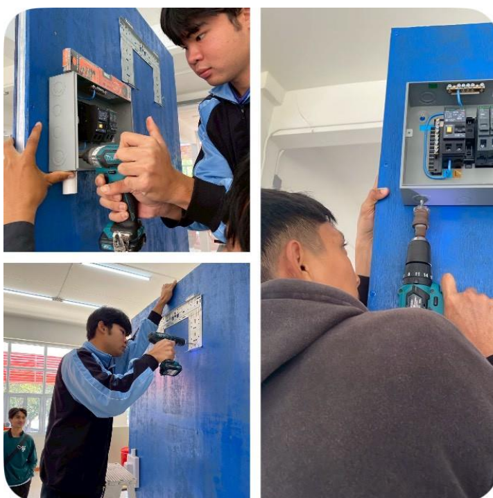
รูปภาพที่ 6 ติดตั้งฐานชุดแอร์ด้านหน้า
