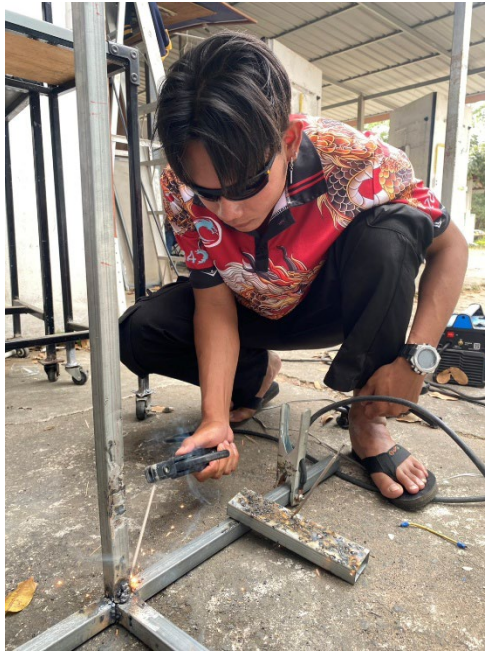
แสดงภาพ การเชื่อมโครงฐาน ของโซล่าเซลล์
